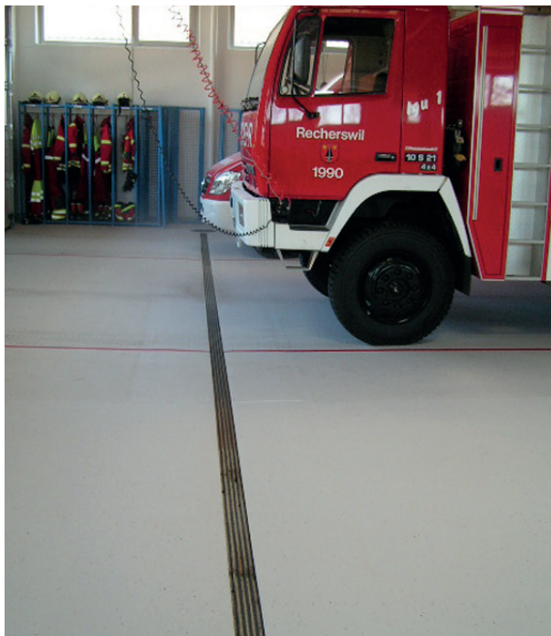
HYDROline Project: Brandweerhal, Zwitserland
