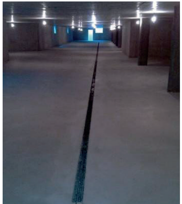
HYDROline Project: Ondergrondse parkeergarage, Zwitserland
